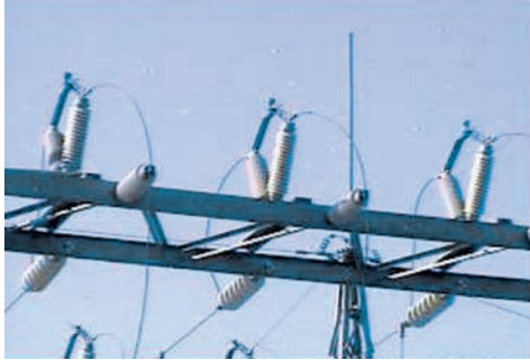
Fig. 5 Confirmarea vizuală a închiderii întrerupătoarelor.
